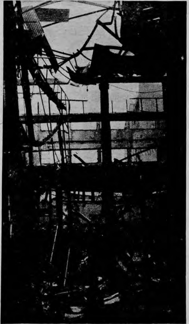
VISTA GENERAL DE LA DESTRUCCION. — Causada por el fuego declarado en la madrugada del domingo en el Cine Raventós de esta ciudad capital. Se aprecian varios pisos del edificio que fueron afectados por las llamas, y en su parte baja el lugar donde estaba la pantalla del cine. (Foto Lizano)
